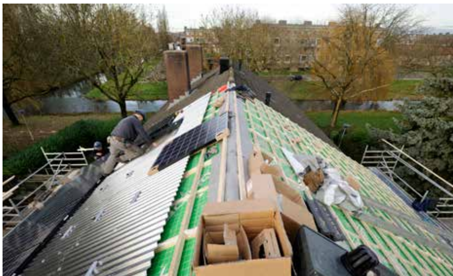
Met zonnepanelen op het dak van nul-op-de-meterwoningen in Arnhem wordt duurzame energie opgewekt.
