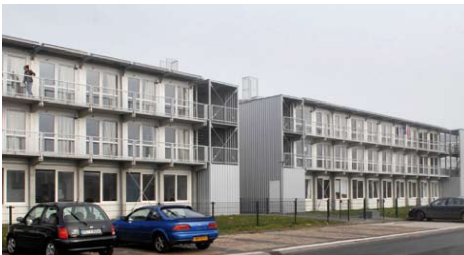
De twee woonvoorzieningen staan naast elkaar. Op de begane grond bevinden zich de (eet)keuken, huiskamer, kantoor- en vergaderruimte en spreekkamers. Daar bovenop zijn twee lagen met containerwoningen.
