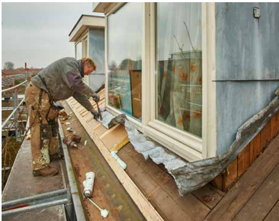
Renovatie van 70 woningen in de Bastiaanstraat in Haarlem. Door spouwmuur- en dakisolatie is het energielabel van E naar C gebracht.
