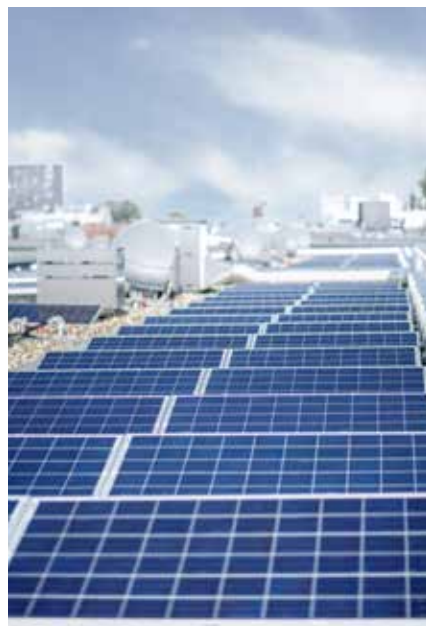
Zonnepanelen op nieuwbouw in Stadstuin Overtoom.
